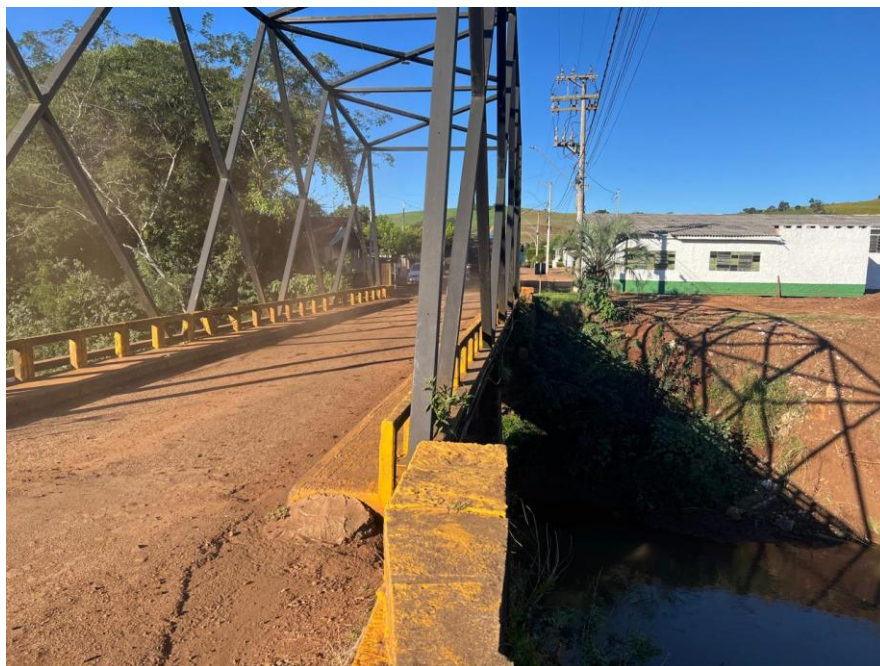
Figura 6 – Localização da Linha de Recalque aérea
