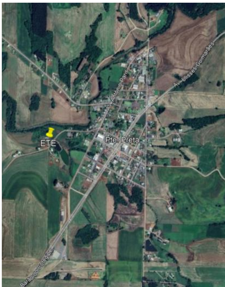
Figura 1 - Localização da ETE em Ponte Preta
